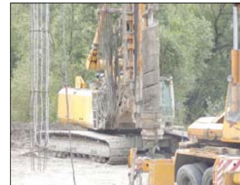
Függőleges szonda telepítése az 5-let Kft egyik építkezésén 2005-ben
