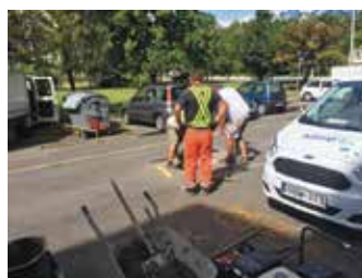
Utak javítása, nyílászárócsere, vizesblokk felújítás
