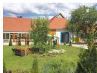
Óvoda, Bölcsőde teljes szigetelés
