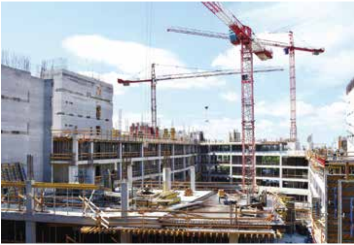
A Telekom épülő székháza
