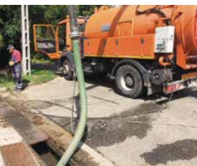
A Barázda és Bajtársnál lévő kereszttrácsos víznyelő tisztítása 07.06-án
