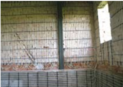
A falba elhelyezett több kilométernyi csőrendszer adja át a föld energiáját: télen fűt, nyáron hűt
