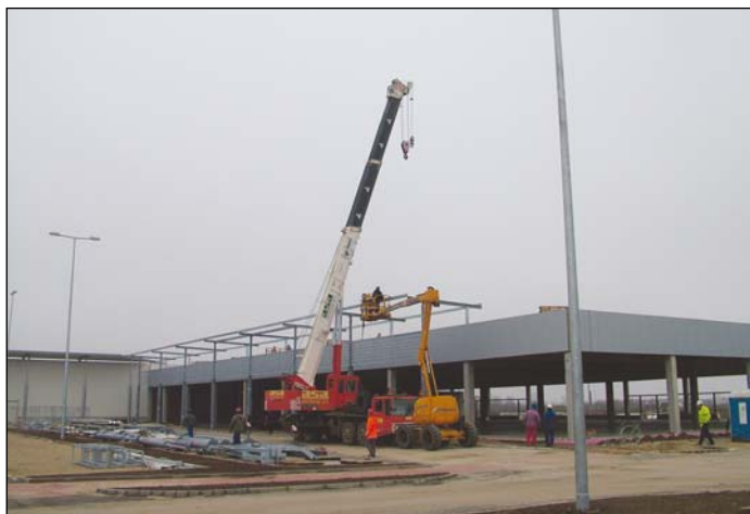
Jó ütemben halad a Family Center építése is
