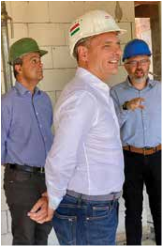
Erdőkerten az épülő Szőlőfürt óvoda megtekintése
