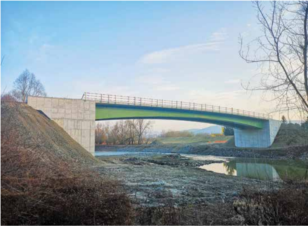
A folyó két oldalán élők 2000 óta várják az új Ipoly-híd felépítését
