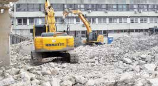
A régi épületek bontásával elkezdődött a kórház felújítása
