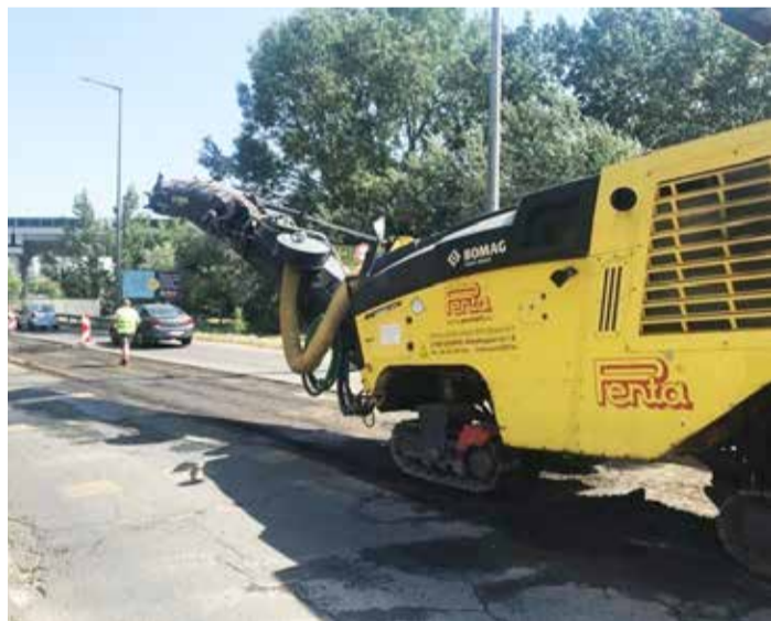
Megkezdődött a nagy forgalmú közlekedési csomópont átépítése
