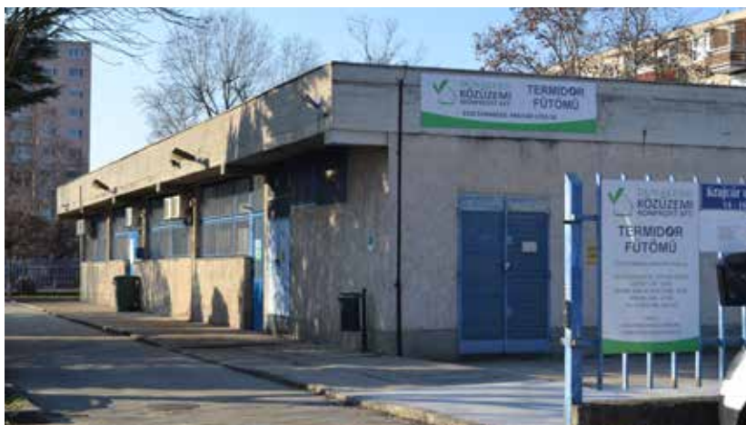
Az önkormányzat pályázati forrásból valósítja meg a Dunakeszi Közülemi Nonprofit Kft. Krajcár utcai ügyfélszolgálati iroda épületének szigetelését, energetikai korszerűsítését
