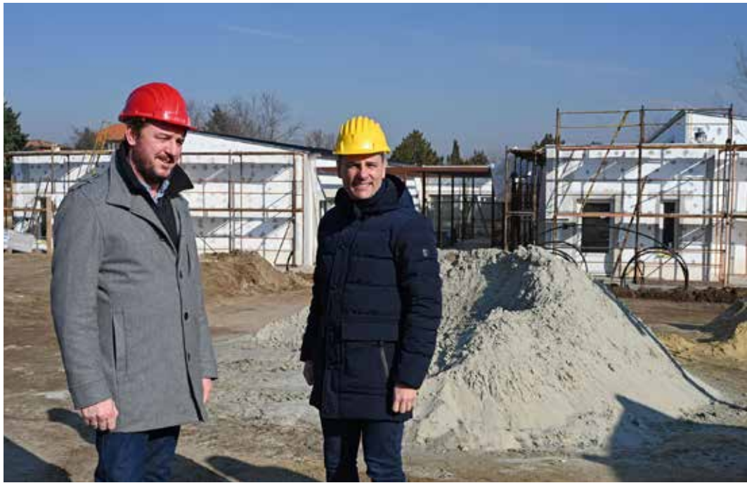
Tuzson Bence: Dunakeszin jelenleg a Napsugár Bölcsőde új épületszárnyát építjük
