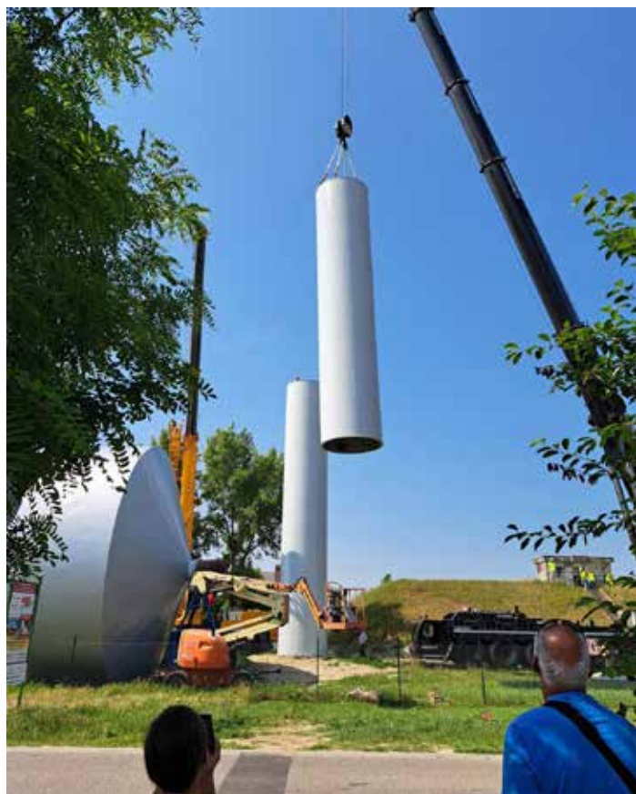
Két tartóoszlopra helyezték fel a víztorony 500 m³-es tartályát
