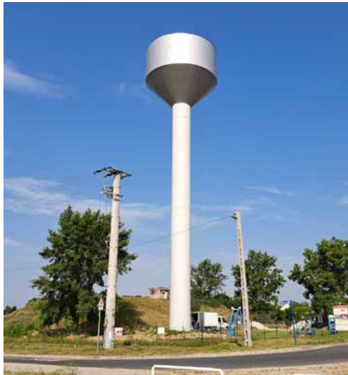
Dunakeszin 40 méter magas, 500 köbméter kapacitású víztorony épült
