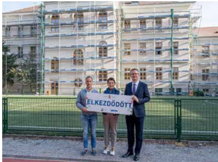
Elkezdődött a 300 éves iskola épületének a felújítása
