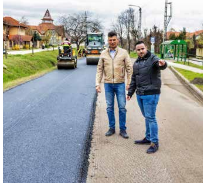
Dióssi Csaba polgármester és Sipos Dávid alpolgármester a helyszínen ellenőrizte a Kossuth Lajos utca felújítását
