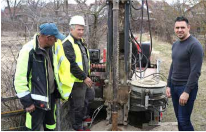
Kammerer Zoltán polgármester a helyszínen ellenőrizte a munkálatok beindítását
