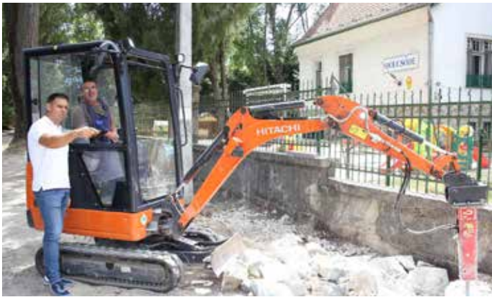
Megkezdődött a járdaépítés a gödi Bolla Árpád fasoron - mutatja Kammerer Zoltán polgármester
